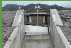
C 起伏ゲート
